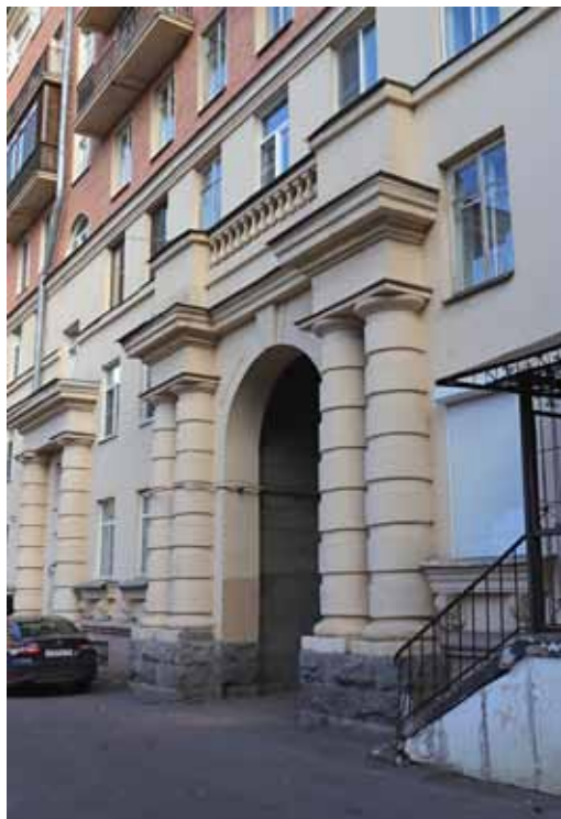
6. Жилой дом. Петербург. Ул. Фрунзе, 16. 1-я половина 1950-х. Автор не установлен. Дворовый западный фасад. Фрагмент. Фото А. Е. Белоножкина. 2024
